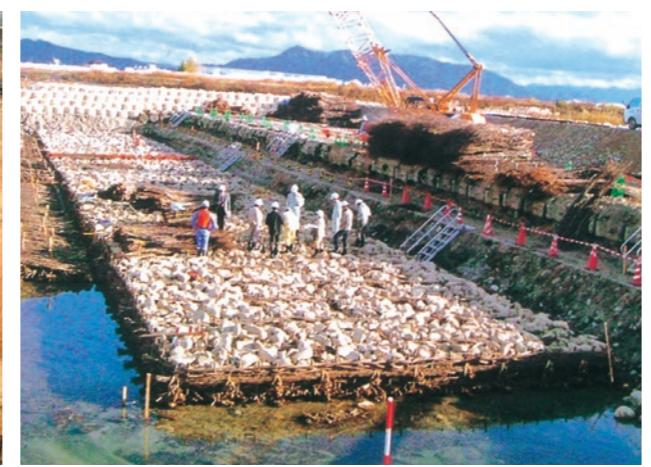
あらかじめ材料になる粗朶を現場に搬入しておき、一日で粗朶沈床の土台を組み上げ、大型クレーンを使い沈設位置を確認してから、川のなかへ沈設する。※
