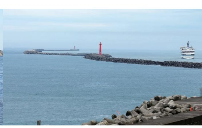
明治38年に完成し、その後沈降や波浪による欠損で嵩あげ工事や延伸工事などの改修が行われた新潟西港の西突堤。陸側から手前にある灯台までの突堤の基礎に粗朶沈床が採用されている。(新潟市中央区)
