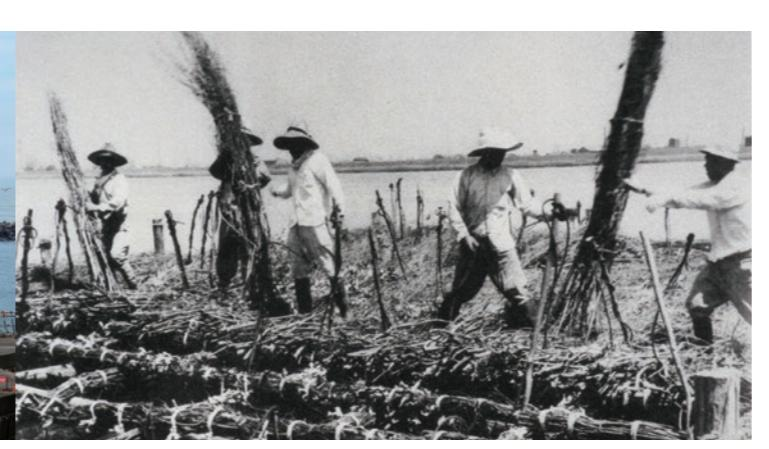
枝をマット状に編む粗朶沈床はオランダの伝統的な水制技術で、オランダ人の粗朶工職人の指導のもと、日本の粗朶職人が組み上げて沈設作業を行った。(IN EEN JAPANSE STROOMVERSnelLINGより)
