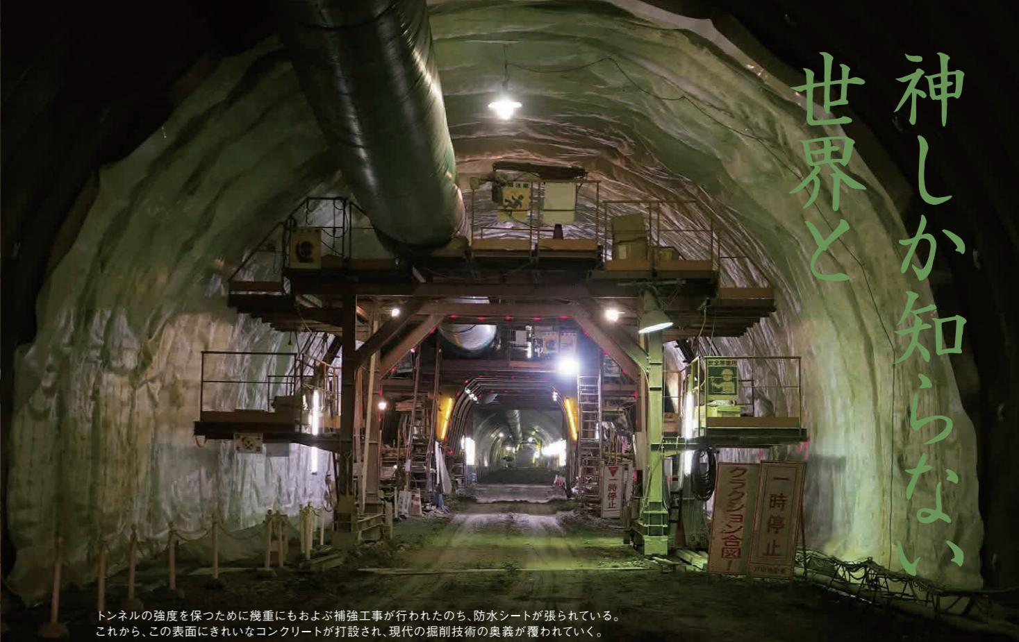
トンネルの強度を保つために幾重にもおよぶ補強工事が行われたのち、防水シートが張られている。これから、この表面にきれいなコンクリートが打設され、現代の掘削技術の奥義が覆されていく。
