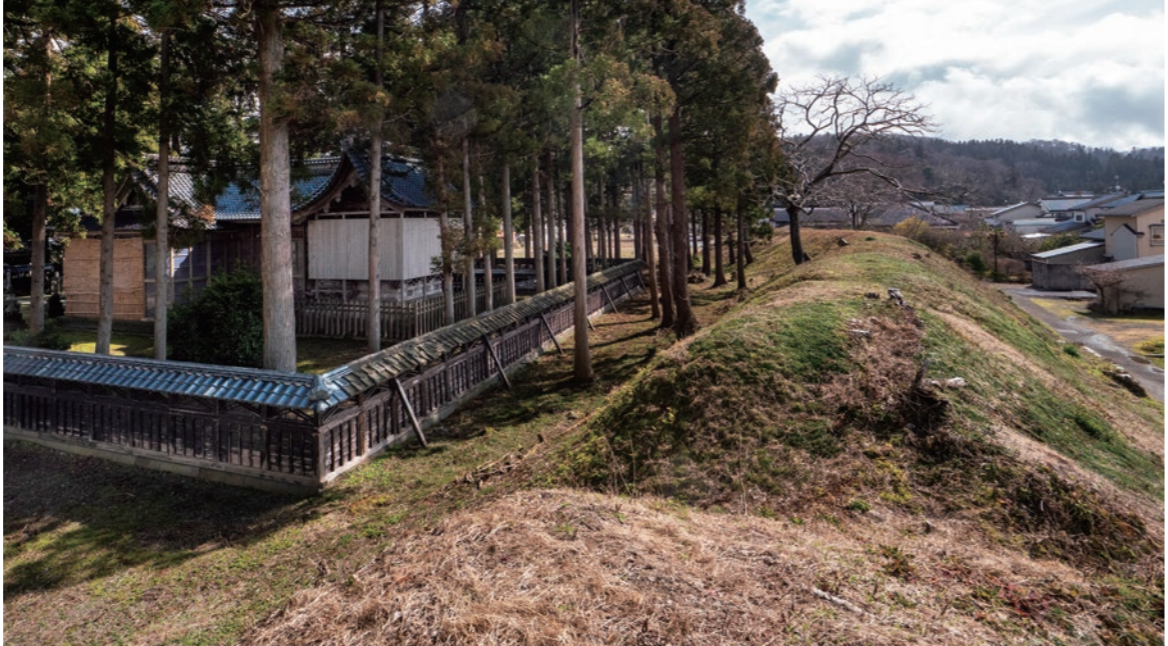
町のなかで突然現れた防衛用の土塁。江戸時代は堀と土塁で町全体が囲まれていた。
