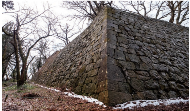
臥牛山山頂に築かれた村上城跡の石垣。堀直寄の時代に大規模な石垣が築かれた。そこから歴代の城主が見た村上市街と日本海が一望できる。
